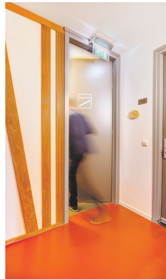
▲ Rook- en brandwerende vluchtdeur.
